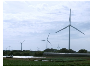
銚子風力発電所
