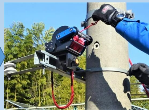
巻取りロープを引き出し対象物へ固定
