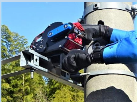
ベース部クランプを締め付け本体固定
