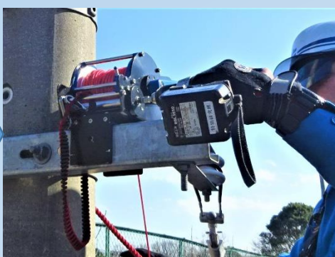
六角シャフトヘドライバービットを差込む
