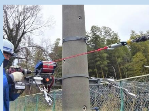
充電ドライバーを操作しロープを巻取る （キックバックに注意）
