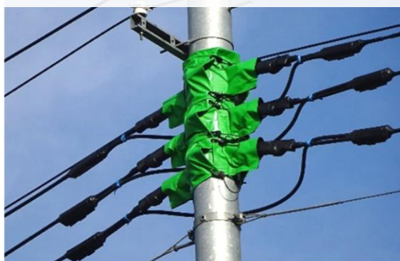
低圧用電柱防護シート（引留用）
