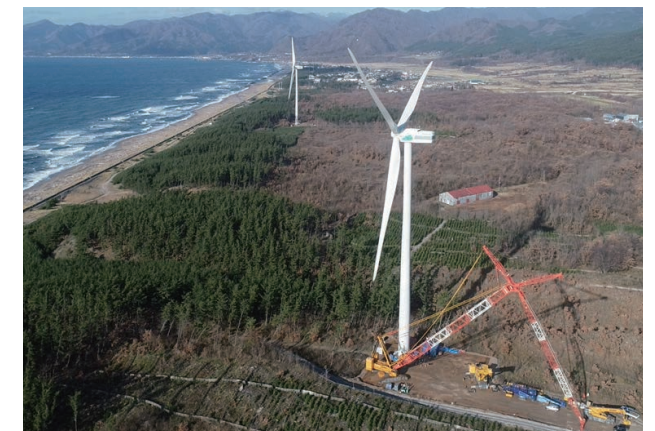
風力発電所建設工事
