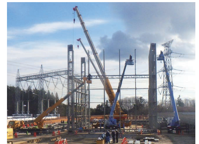
変電所建設工事
