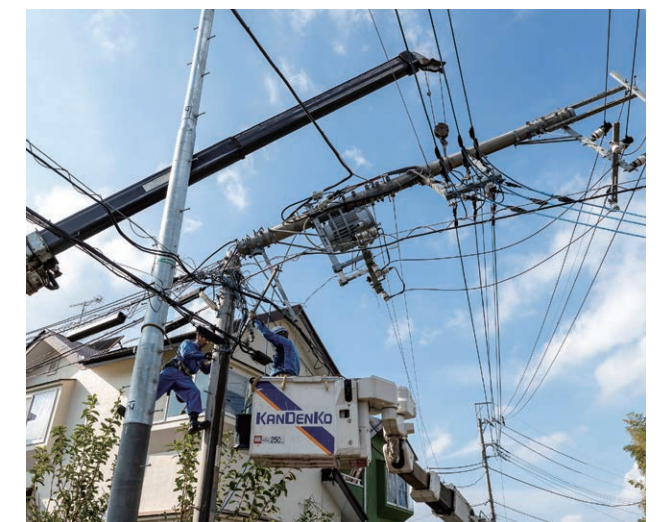
台風により折損した電柱の仮修工事
