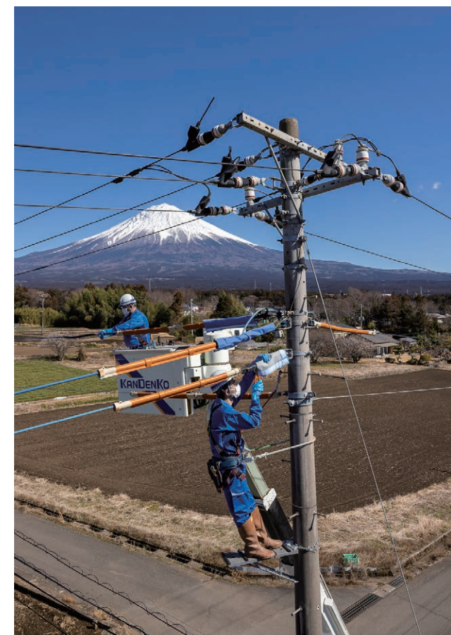
本線設備強化改修工事
