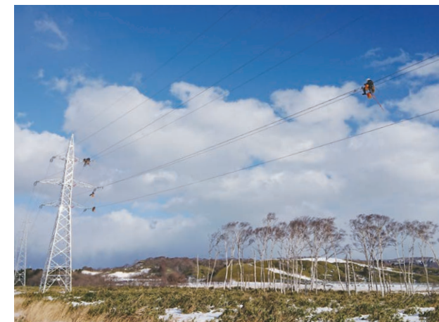
送電線建設工事
