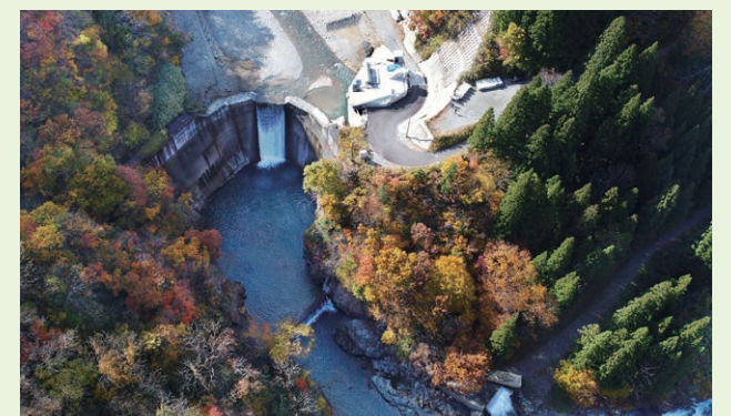
砂防ダムと上結東水力発電所全景
