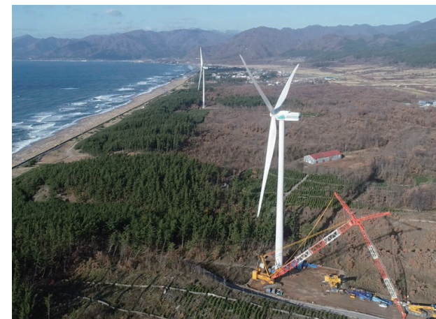
風力発電所建設工事
