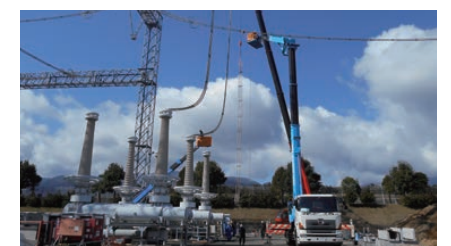
変電所設備増強工事
