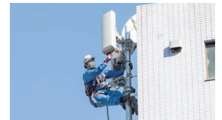
携帯電話基地局設置工事
