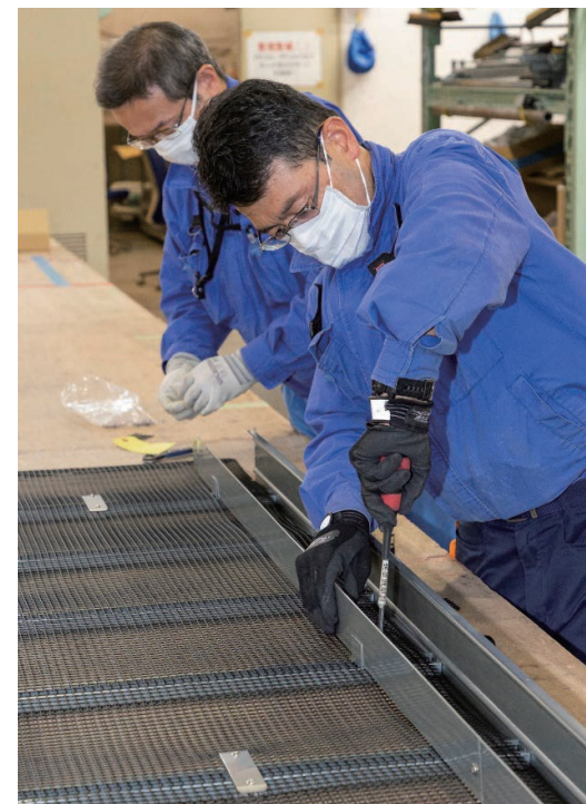
ケーブルラック組立作業
