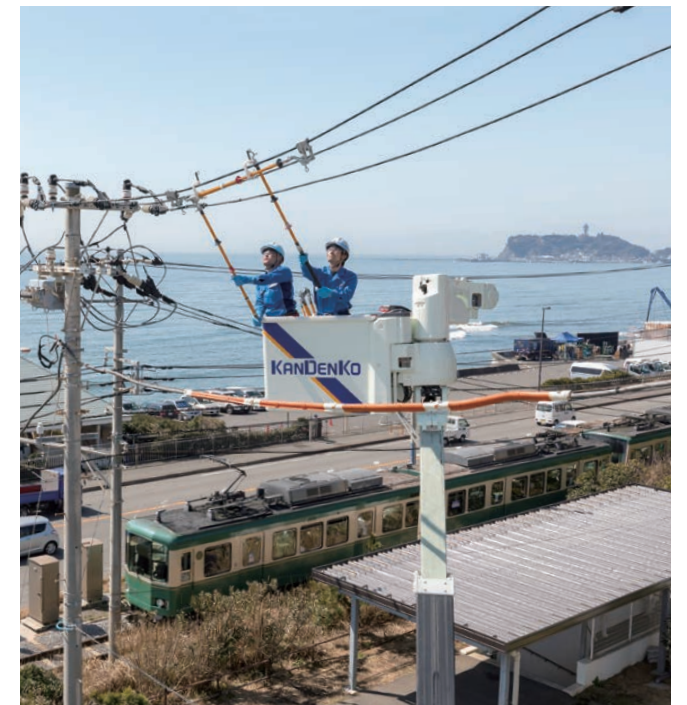
架空配電線工事（神奈川県）
