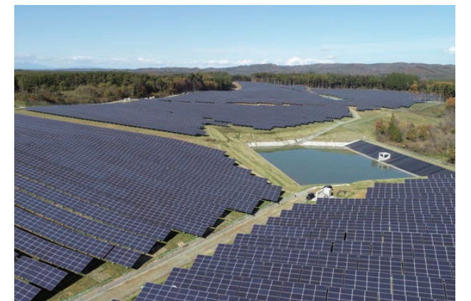
太陽光発電所建設工事
