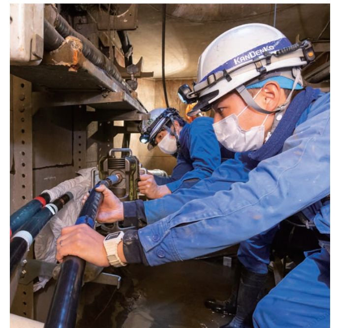
地中配電設備のケーブル接続工事（東京都）
