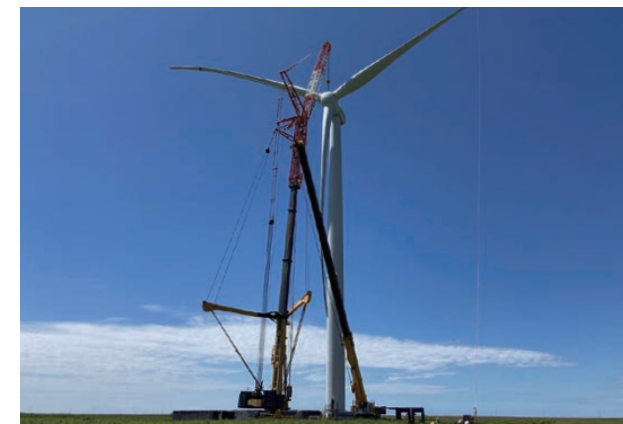
風力発電所建設工事
