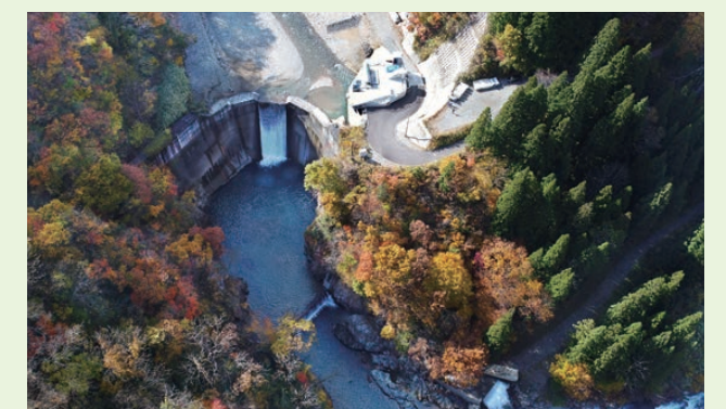
砂防ダムと上結東水力発電所全景
