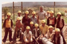
1981年 ネパール配電線網整備工事
