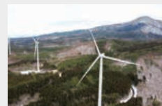
2024年 深浦風力発電所竣工
