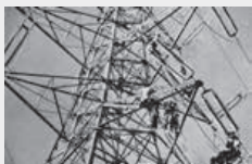
1940年代後半 大型送電線工事が本格化
