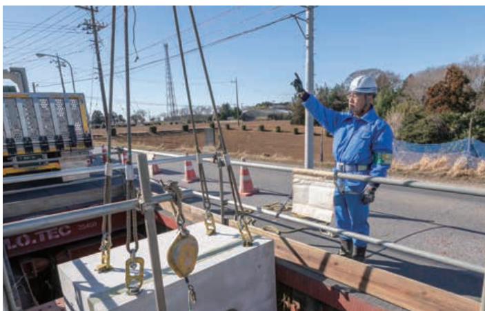
電力用マンホール設置工事（茨城県）
