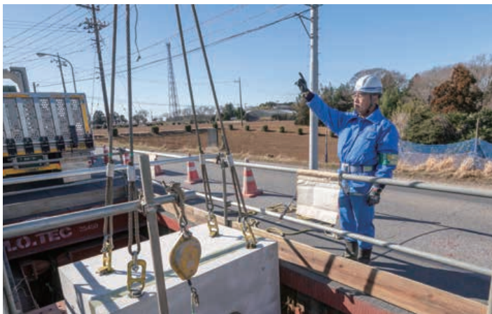
電力用マンホール設置工事（茨城県）
