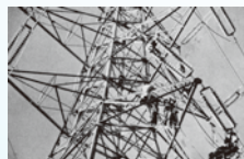
1940年代後半 大型送電線工事が本格化
