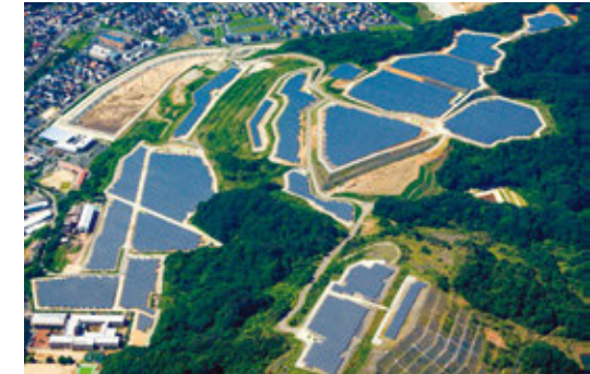
⑫ 嘉麻第一太陽光発電所 (福岡県)
