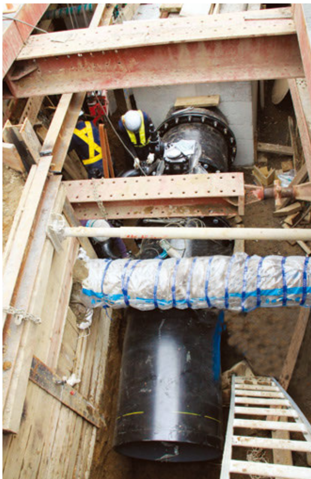
▲ 上水道配水本管工事
