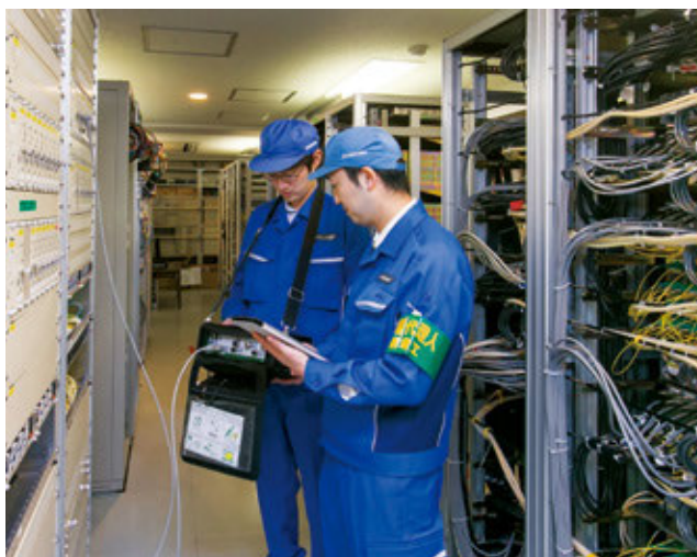
CATV局内での機器調整作業
