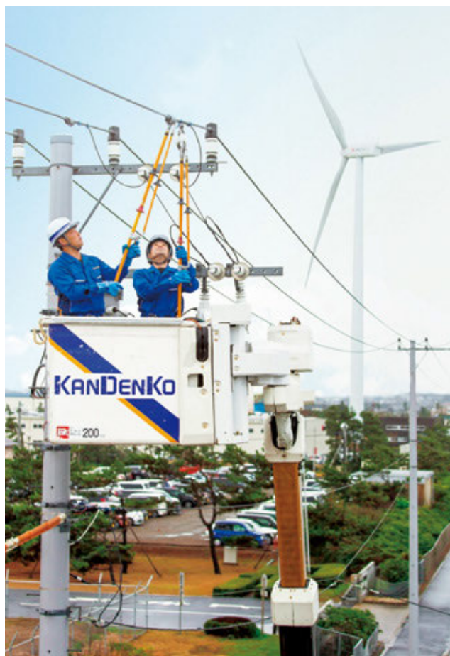
ホットスティックを用いた架空配電線工事
