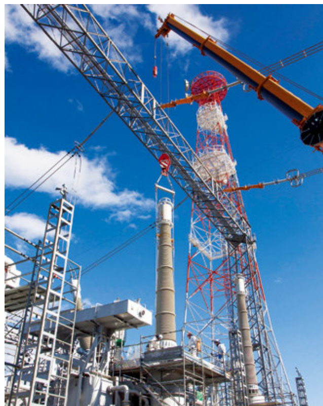
500kV変電所のしゃ断器取替工事
