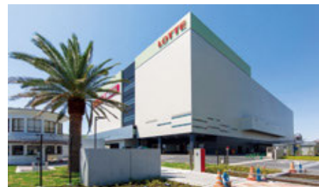
④ (株)ロッテ 浦和第6工場 (埼玉県)
