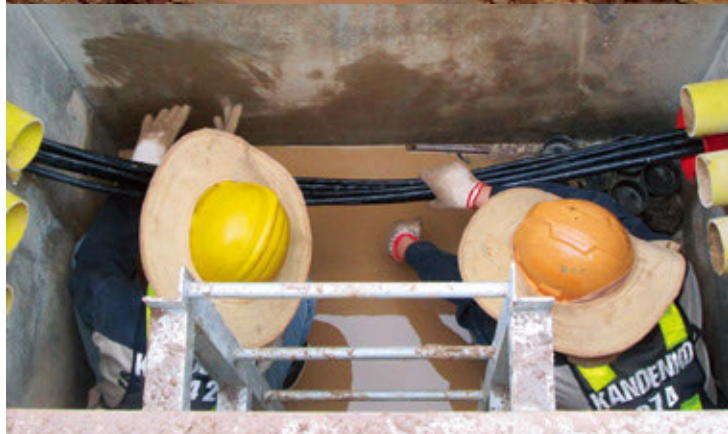
▲ 泥水を処理しながらの配管・ケーブル敷設作業
