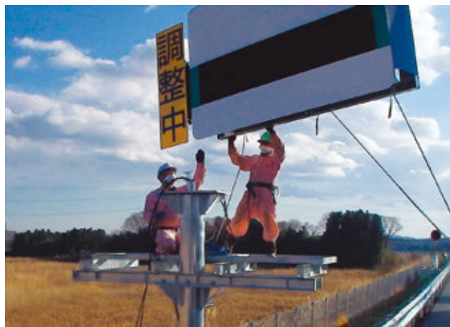
▲ 高速道路情報板設置工事
