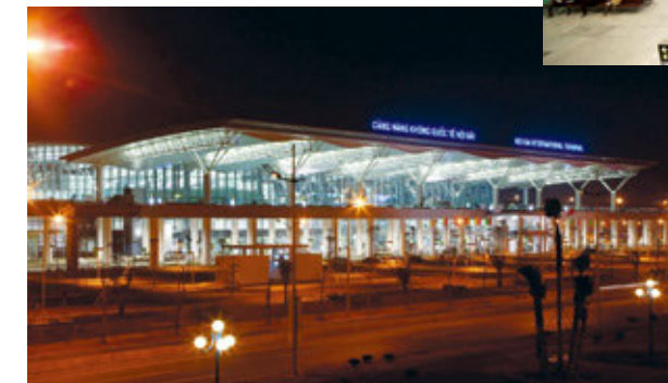
⑭ ノイバイ空港第2旅客 ターミナルビル (ベトナム)
