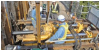
▲小口径推進工法を用いた鉄道線路耐震工事
