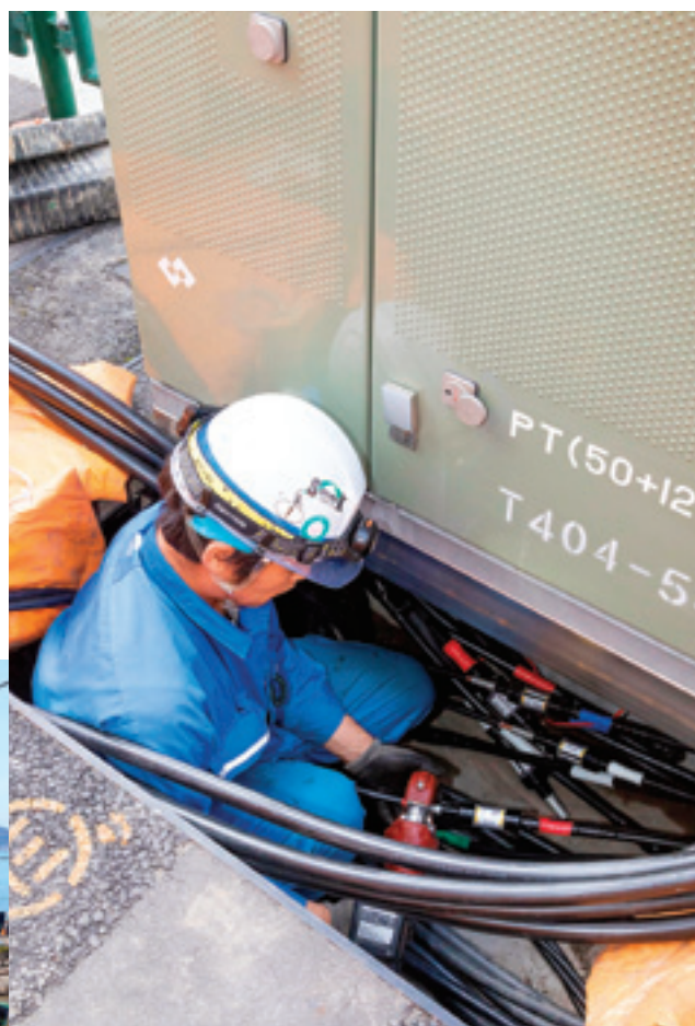
地中配電設備のケーブル接続工事
