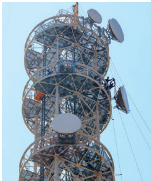
無線通信アンテナ設置工事
