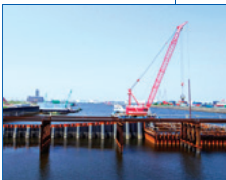
▲ ボート・カヌーの競技会場の建設が進む中央防波堤
