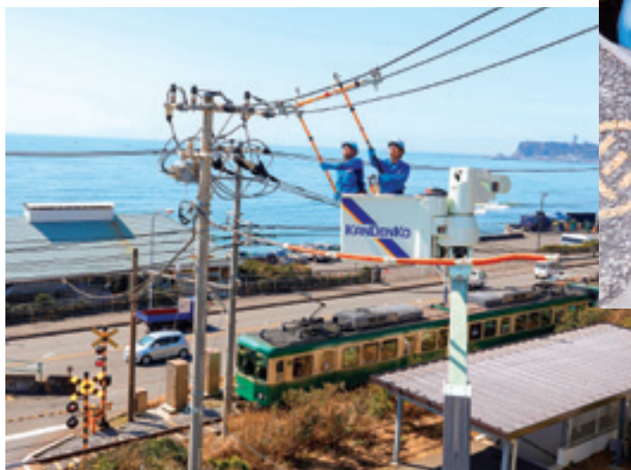
間接活線工法による架空配電線工事
