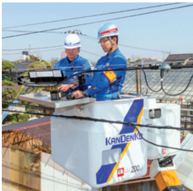
ケーブルテレビ設備更新工事
