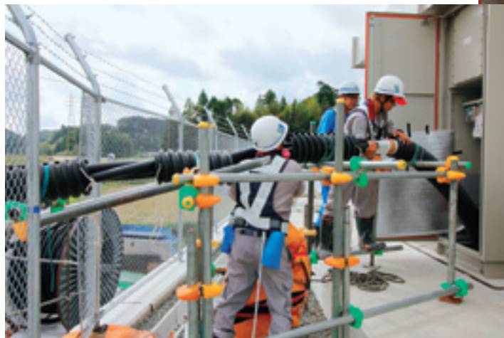
再生可能エネルギー系統連系線工事
