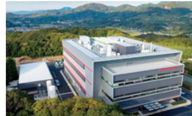
⑧ 浜松ホトニクス(株)都田製作所第3棟(静岡県)
