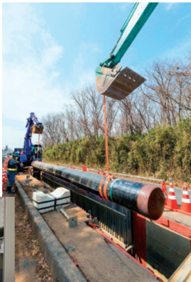
ガス管理設工事
