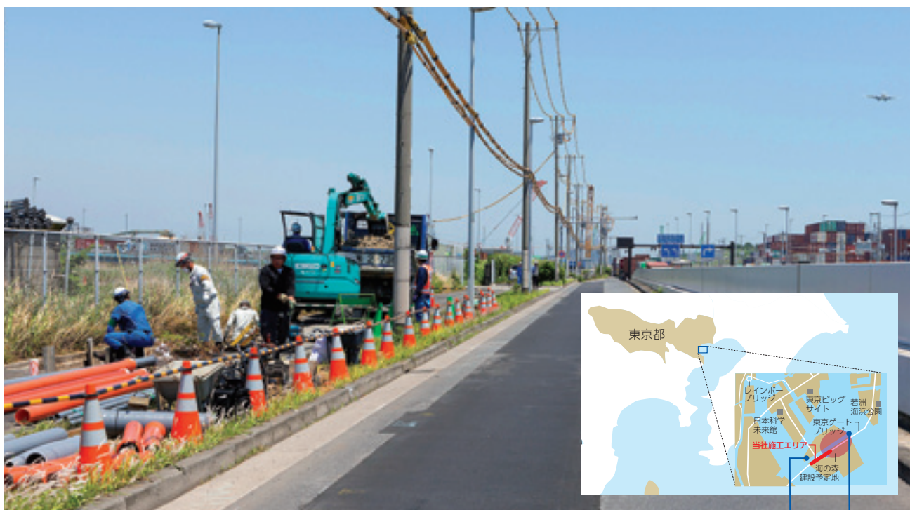
▲ 日中・夜間合わせて、15名前後が稼働する電線地中化の現場
