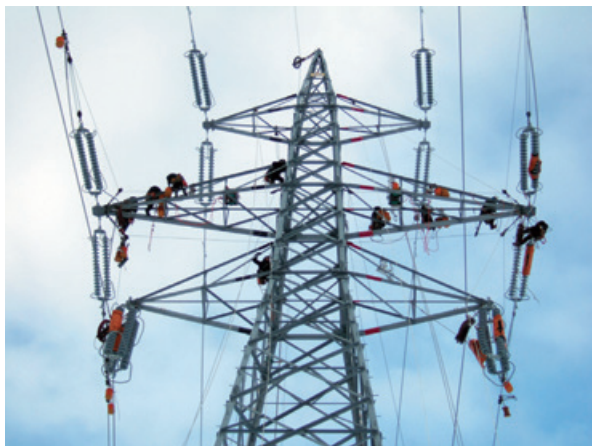
鉄塔上での碍子取り付け
