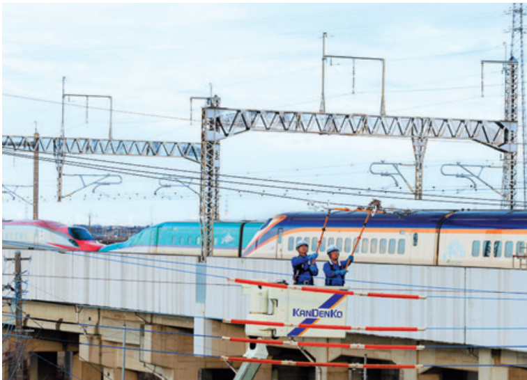
間接活線工法による架空配電線工事（埼玉県）
