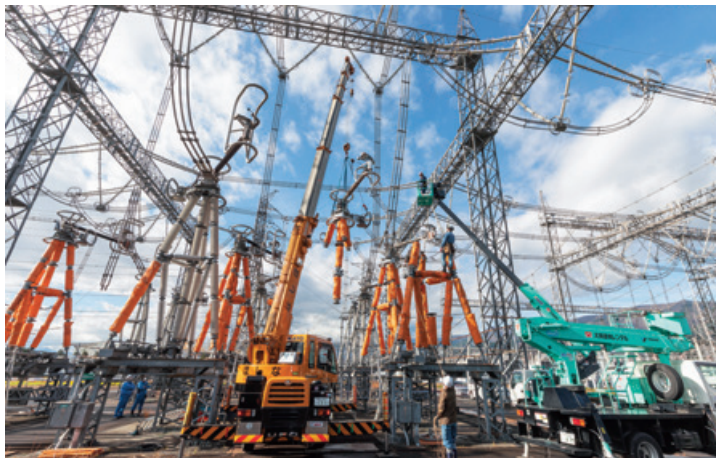
変電所開閉器交換工事（静岡県）
