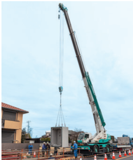
電力用マンホール設置工事（埼玉県）
