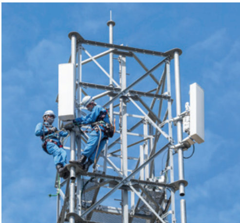
携帯電話基地局新設工事（千葉県）
