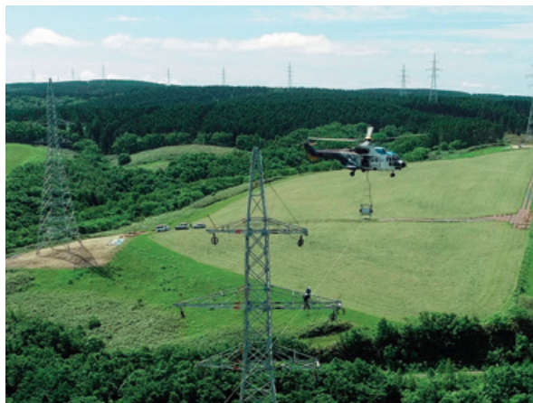
ヘリコプターを使用した延線作業
