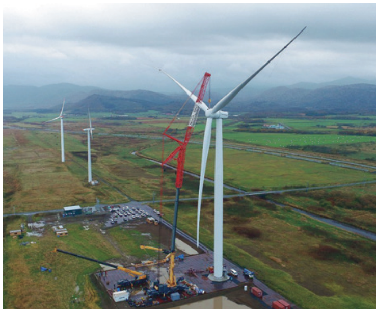
大型クレーンを用いたブレードの設置（ユーラス遠別ウインドファーム）
