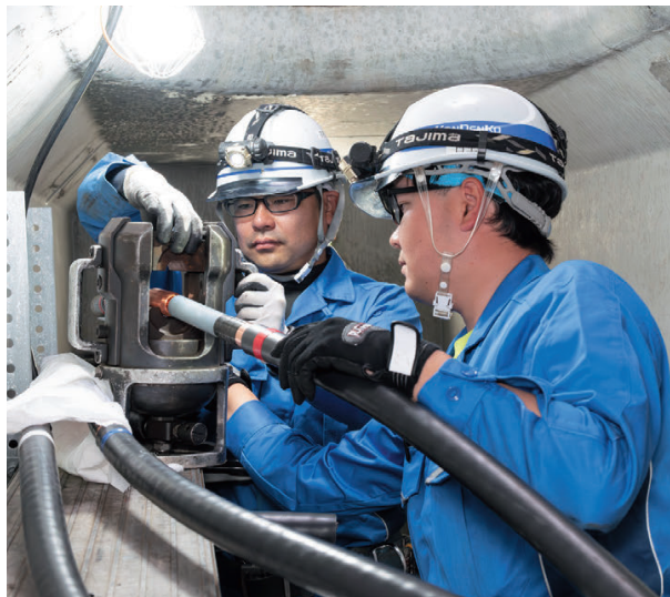
地中配電設備のケーブル接続工事（茨城県）
