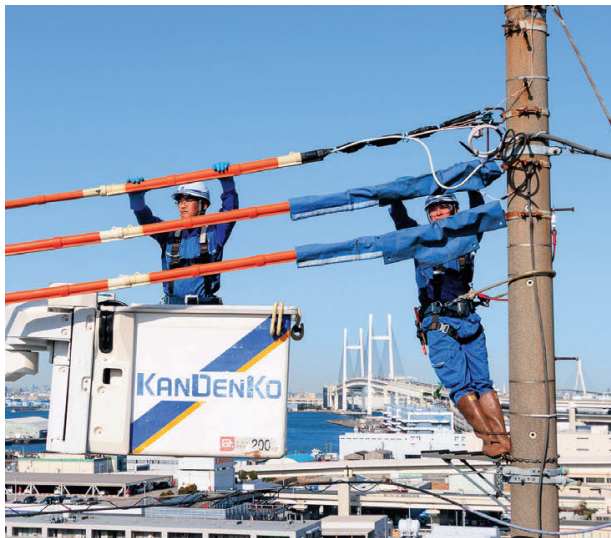
本線設備強化改修工事（神奈川県）
