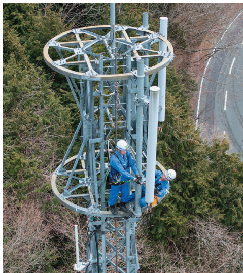
無線通信アンテナ設置工事（茨城県）
