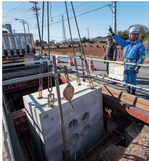
電力用マンホール設置工事（茨城県）
