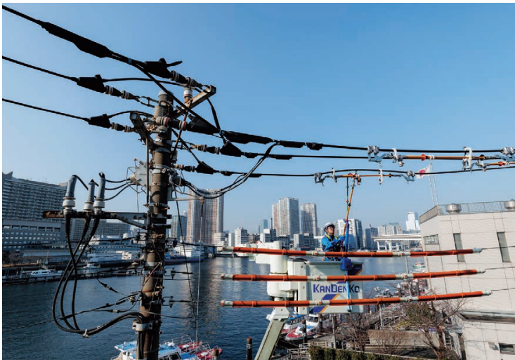
アシストツールを用いた間接活線工法による架空配電線工事（東京都）
