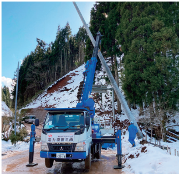
電柱新設作業
