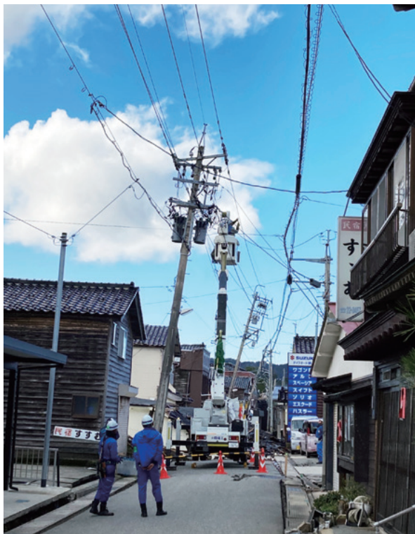
電柱傾斜改修作業
