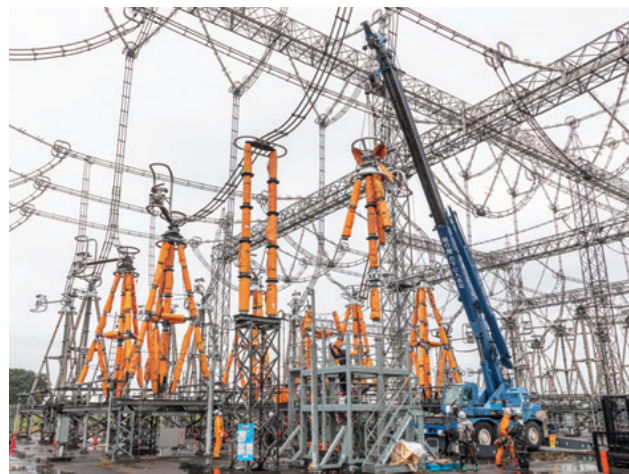
変電所開閉器交換工事（茨城県）
