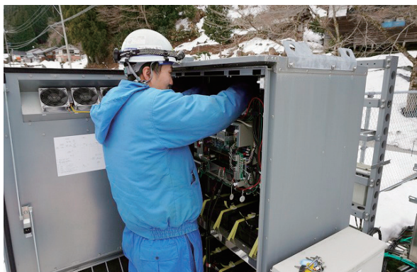
通信障害復旧作業
