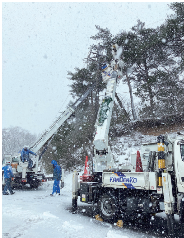
損傷した配電設備の復旧作業
