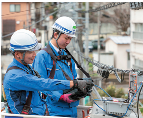
CATVケーブル接続工事（神奈川県）
