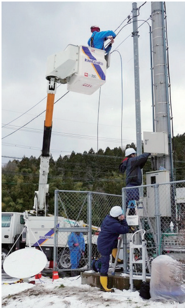
通信設備仮復旧作業
