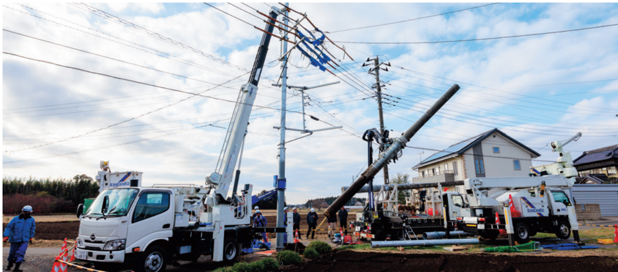
電柱の運搬・掘削・建柱を1台で実現する次世代建柱車を使用した作業実証試験（茨城県）
