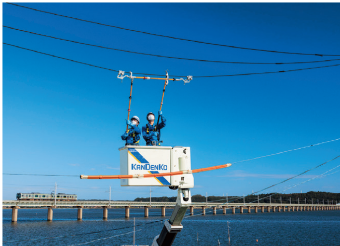
間接活線工法による架空配電線工事（茨城県）
