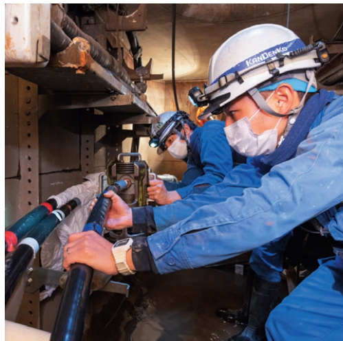
地中配電設備のケーブル接続工事（東京都）
