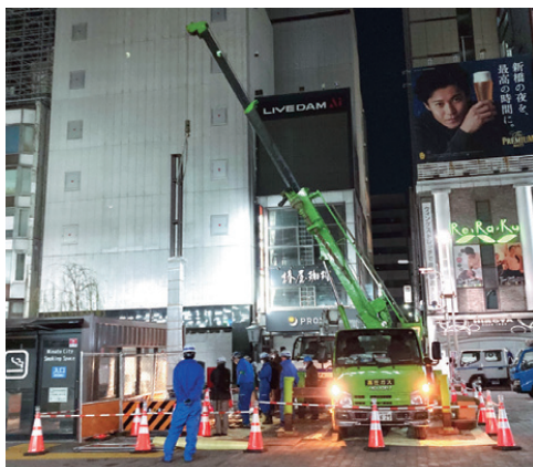
5G普及拡大に向けた スマートポール新設工事（東京都）
