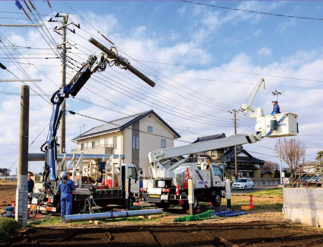
電柱の運搬・掘削・建柱を1台で実現する次世代建柱車を使用した作業実証試験（茨城県）
