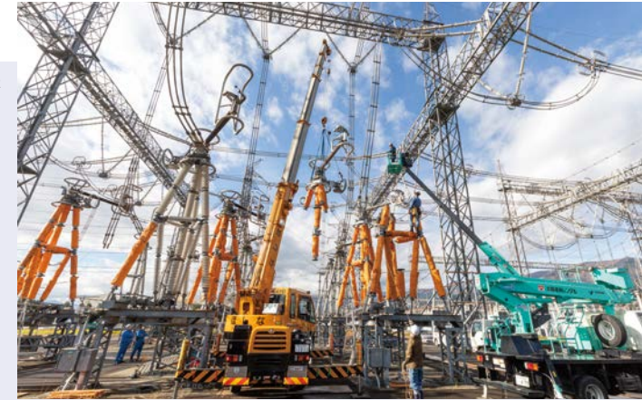
変電所開閉器交換工事 (静岡県)
