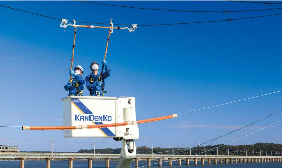
間接活線工法による架空配電線工事（茨城県）
