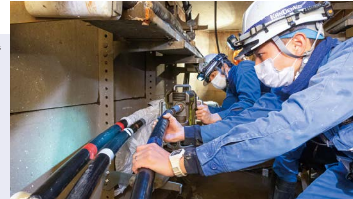
地中配電設備のケーブル接続作業 (東京都)
